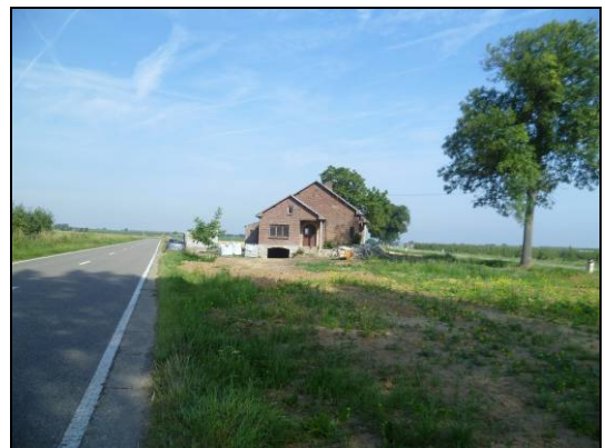
Foto 12 Bestaande zonevreemde woning langs de Oude Katsei
