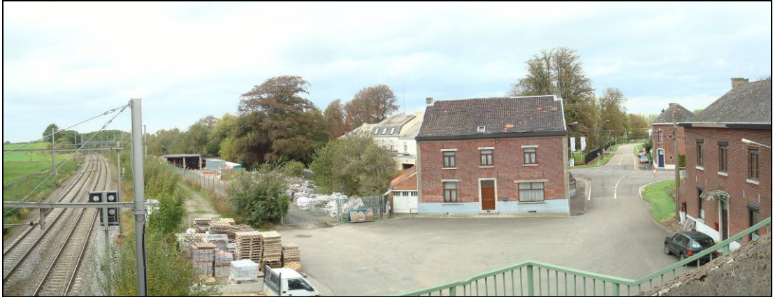
Foto 9 Zicht van op de voetgangersbrug over de spoorlijn
