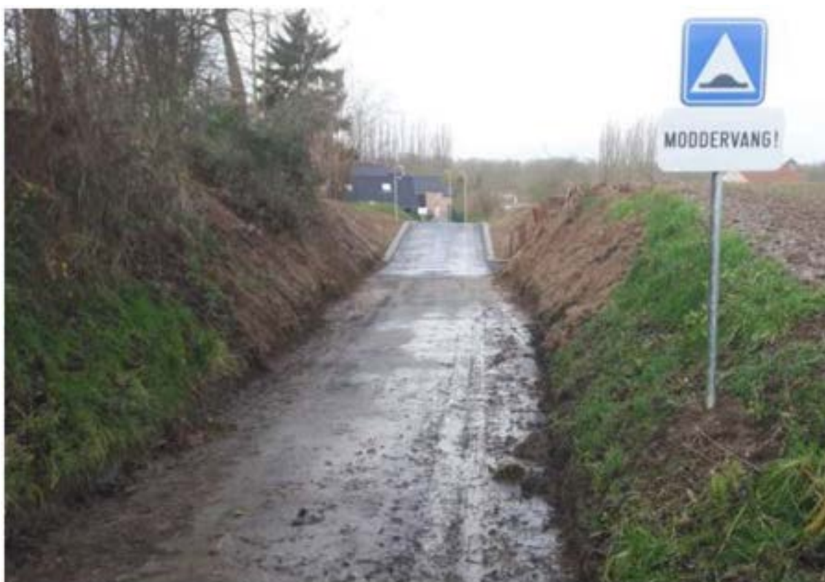
Modderopvangdrempel zijweg Nielstraat
