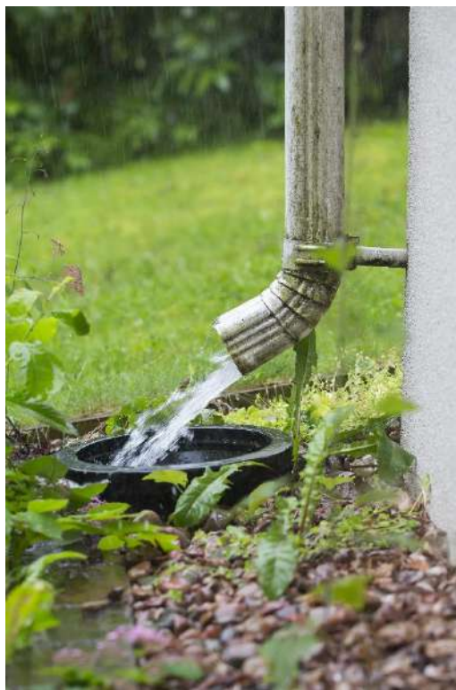
Figuur 75: Afkoppelen dakafvoer van het afvoerstelsel
