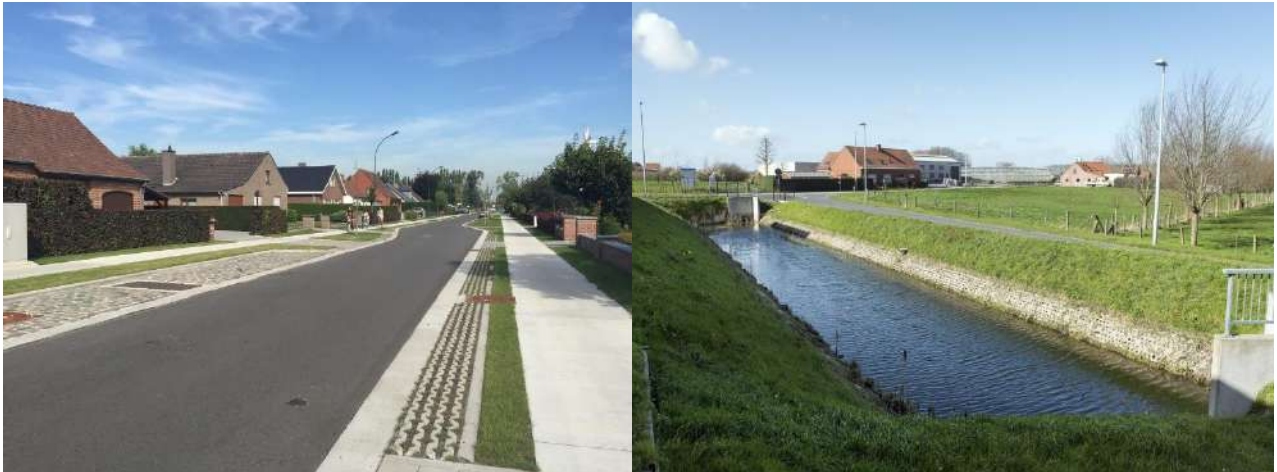
Figuur 77: Links: Lokale infiltratie wegverharding en fietspad. Rechts: Infiltratiebekken
