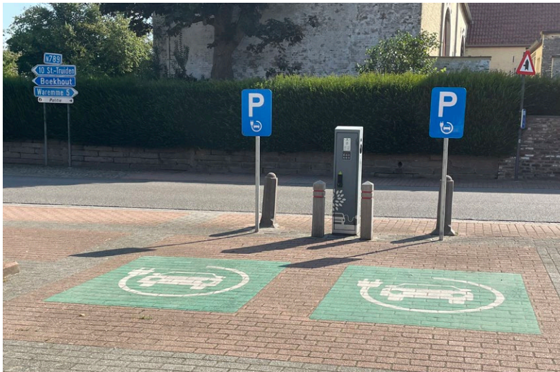
Laadpaal Willy Vannitsenplein
